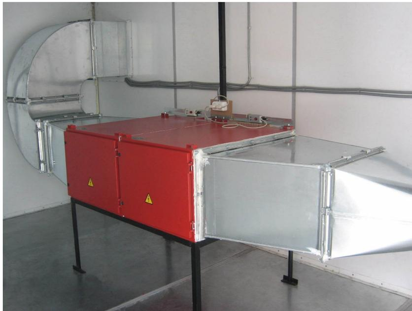
**VIII. Вентоборудование для удаления загрязненного воздуха (или нагнетания чистого воздуха) от временных рабочих мест, в том числе из емкостей, трюмов, судовых отсеков, колодцев**
